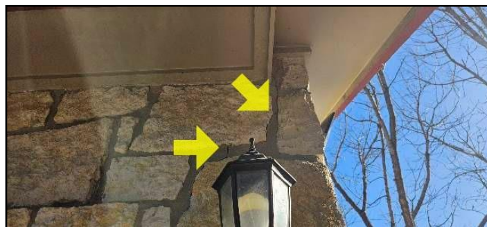
35. Mortar deterioration
