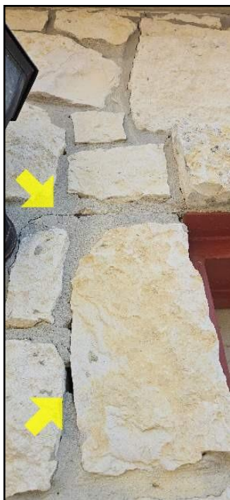
34. Mortar deterioration
